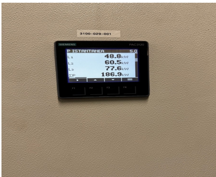
Fig 4.1 - Multimetro raffigurante la potenza istantanea
