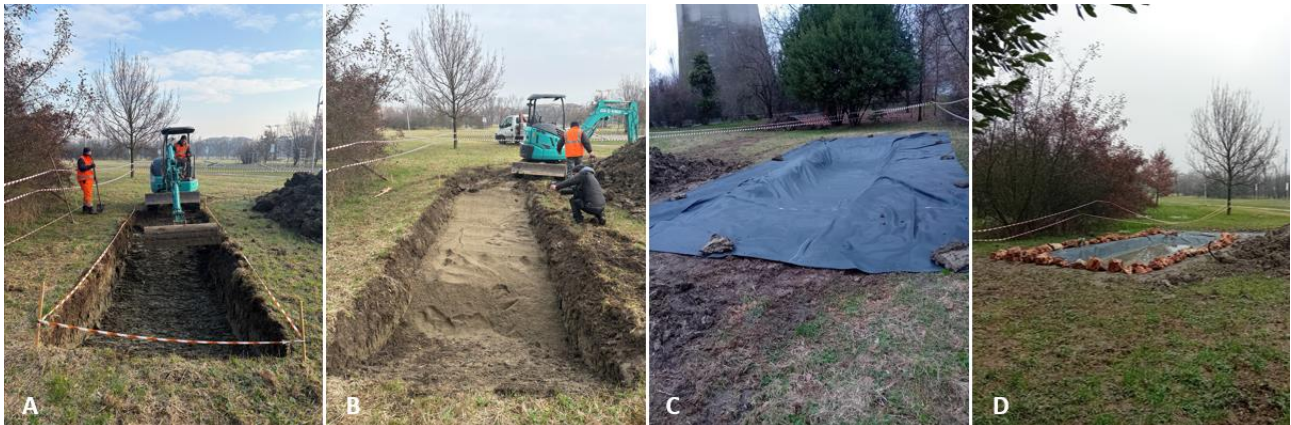
Fig. 12 (A-D). Lavori di scavo eseguiti il 2 Febbraio 2026 mattina e pomeriggio. Nello specifico: (A) inizio dei lavori di scavo; (B) disposizione di uno strato di sabbia; (C) rivestimento con il telo HDPE; (D) posizionamento del travertino rosa.
