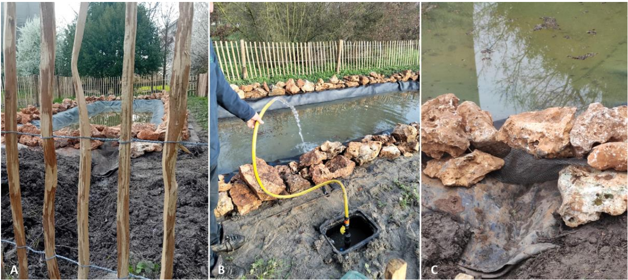
Fig. 13 (A-C). (A) Paletti della recinzione a ganivelle con filo di ferro che li tiene uniti (10/03/2026); (B) pozzetto posizionato all'interno della recinzione per regolare il livello dell'acqua (13/03/2025); (C) rete in plastica che impedisce la fuoriuscita dei girini (05/03/2026).
