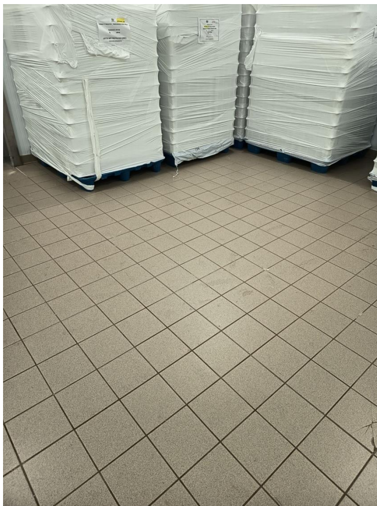
BRC 4.11.1/IFS 4.10.2: Foto pavimento cella
